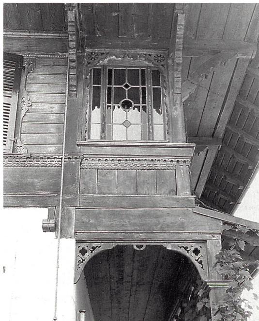
Jakob Kästli war auch der Baumeister der Nervenklinik Wyss in Münchenbuchsee. Er baute 1890 das grosse Bauernhaus am Sonnenweg 16. Darin wohnten Patienten, die in der Landwirtschaft mitarbeiteten. (Foto: Robert Walker)
