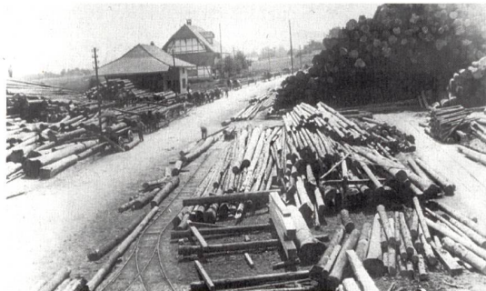
Jakob Kästli errichtete als Zimmermeister an der Bielstrasse ein Baugeschäft und eine Sägerei für den Holzhandel. Um eine Verwechslung mit seinem Bruder zu vermeiden, werden er und seine Nachkommen im Volksmund die «Hölzigen» genannt. Der Brand von 1977 brachte das Geschäft zum Verschwinden. (aus: Alt-Buchsli, Fotoalbum zusammengestellt von Willy Brand, hrsg. von der Gemeinde Münchenbuchsee, 1980)
