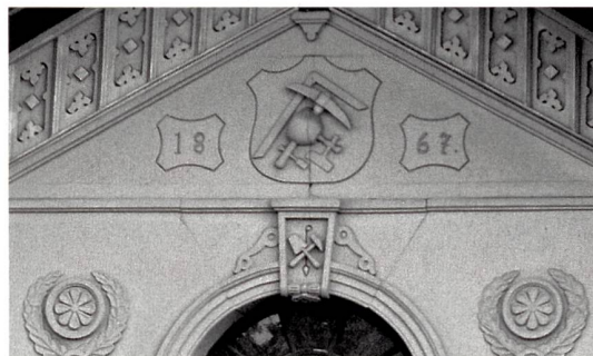
Im Wappen des Giebfeldes die Insignien des Steinhauers und auf dem Schlussstein die Werkzeuge des Baumeisters. Johannes Kästli und seine Söhne werden im Volksmund die «Steinigen» genannt. (Foto: Georges Herzog)
