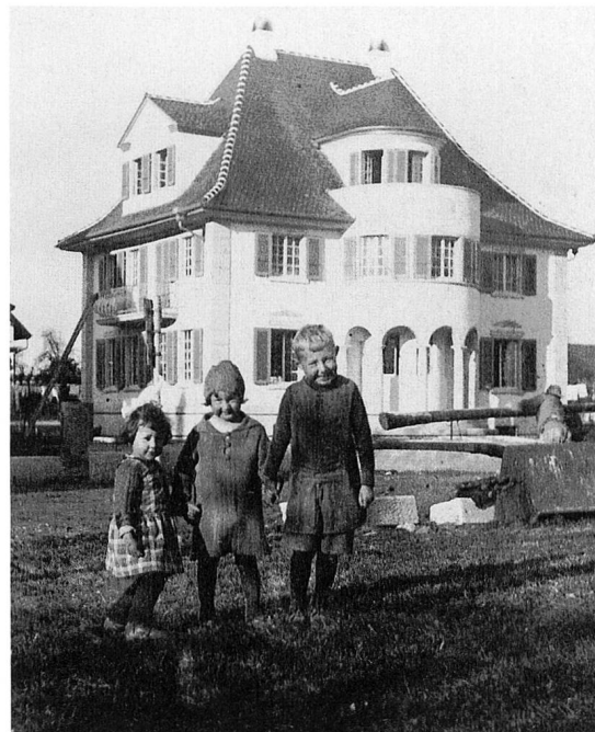
Haus Stierli, Mettenwylstrasse 9, Luzern. Traditionelle Architektur, nur die Rundbogenarkade beim Vorbau verrät die Handschrift Ebersolds. (Quelle: Fotoalbum von A. Ebersold)
