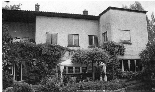
Haus Amonn, Bitziustrasse 53, Bern, 1934 von Ebersold erbaut. Der Dachrand und die gerundeten Kanten des vorspringenden Volumens erinnern an das Haus am Hirschsprung in Berlin-Dahlem. Im Sockelbereich Klinker. (Foto: R. Walker)
