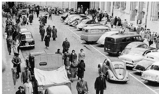
Vor dem Neubau des Bahnhofs mussten die Reisenden beim Ein- und Aussteigen die Geleise überqueren (1956).
