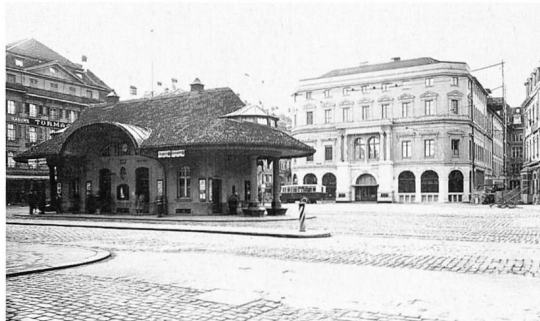
Die Tramhaltestelle am Bahnhof vor und nach dem Umbau 1930/31.
