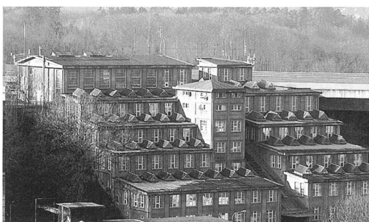
Ittigen, sog. Stufenbau von 1924/25. Die einstige Nitrozellulosefabrik ist ein Industriedenkmal von nationaler Bedeutung. Nach der Umnutzung bildet sie eine ideale Hülle für mannigfaltige Aktivitäten. (Foto: Denkmalpflege des Kantons Bern, Elisabeth Schneeberger)
