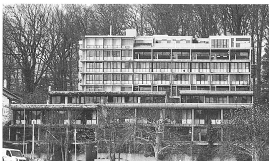
Brugg, Mehrfamilienhaus Rainpark 16, erbaut 1970 durch das Atelier 5. Ein Glücksfall für das Denkmal: 20 Stockwerkeigentümerschaften entschieden sich für eine einheitliche Restaurierung und den Verzicht auf Perfektionismus. (Foto: Kurt Joss, Brugg)
