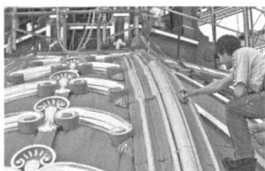
Die Neuvergoldung der Hauptkuppel, 2007 (Foto: Aebi & Vincent Architekten, Bern, Thomas Telley)
