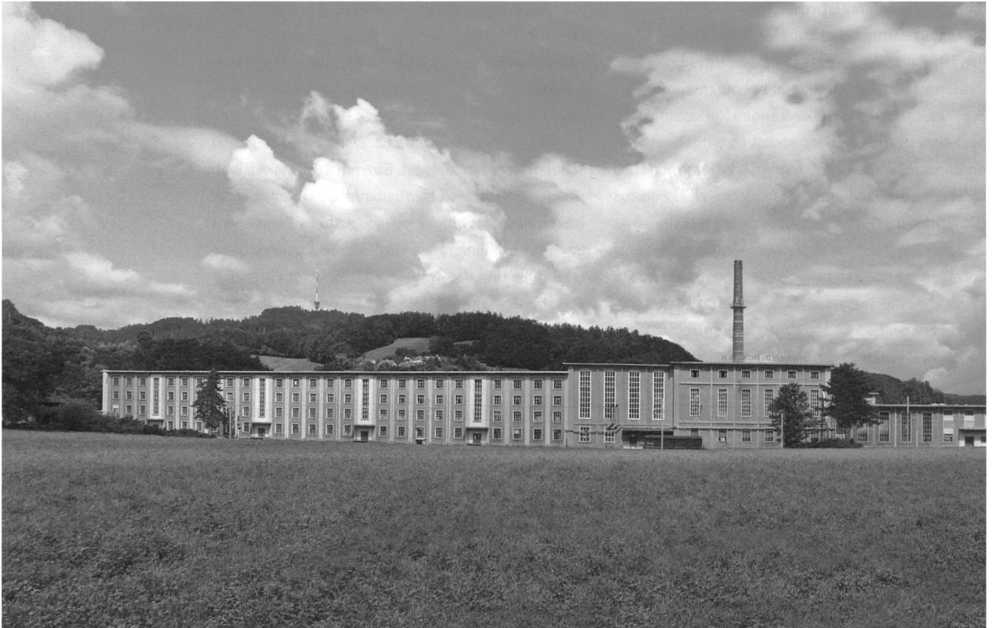
Ansicht Hauptfassade 2010 (Tobias Erb)
