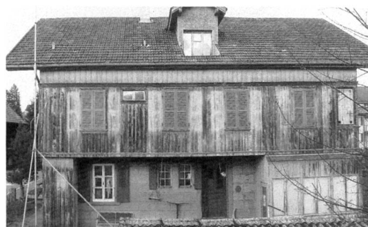
Vor dem Umbau (Fotos: Verein für Ortsbildschutz Münsingen)
