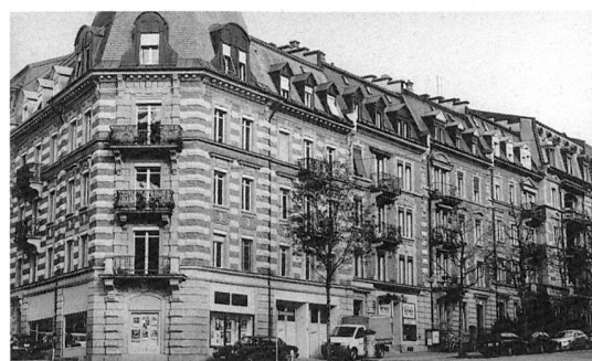
Naturstein-gegliederte Sichtbacksteinfassaden von Otto Lutstorf und Antonio Perello am unteren Ende der Spitalackerstrasse, entstanden 1906 – 10
