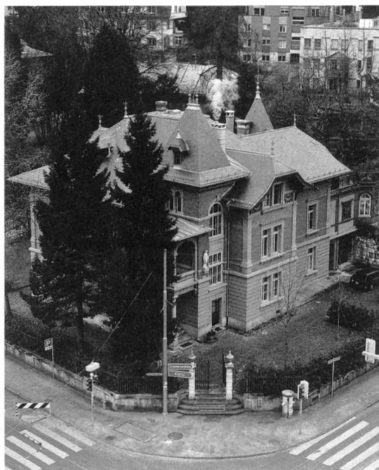
Villa des Architekten Christian Trachsel im Winkel von Seftigen- und Schwarzenburgstrasse beim Eigerplatz, erbaut 1894
