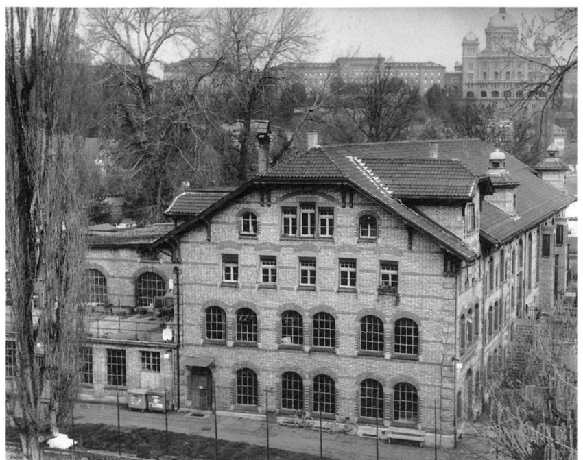
Dampfzentrale von Eduard Joss an der Marzilistrasse 47 in Sichtweite der Bundeshäuser
