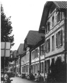
Sichtbacksteinerne, nach- träglich teilweise verputzte Reihenhäuser von Christian Trachsel am Drosselweg bzw. Fichtenweg in der hin- teren Länggasse
