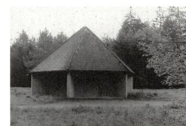
Brunnenstube in der Belpau
