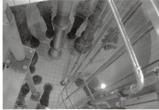
Filterhalle des Wasserreservoirs Könizberg
