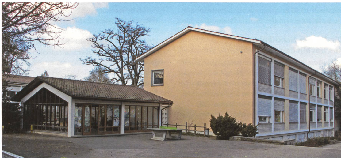
> Schulanlage Unteres Murifeld, Ansicht der Haupt- fassade des Primarschul- hauses mit vorgelagerter Pausenhalle, 2014.
