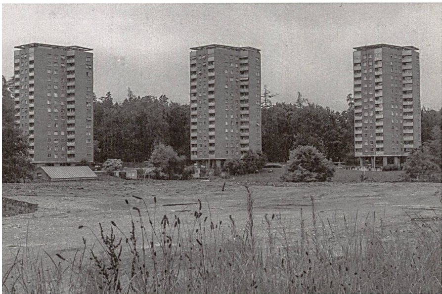
◀ 24 ▲ 25 Die drei Hochhäuser an der Holligenstrasse 101, 109 und 121 am Rand des Könizbergwalds aus den Jahren 1960-1961 von Willi Althaus (1912-1996). Im Originalzustand (links: Sichtbacksteinfassaden und schwebende Betonelemente über der Attika) verblieb auf Dauer nur der Bau rechts aussen, derweil die beiden anderen im Zuge von Nachisolierungen mit Backsteinattrappen verkleidet wurden und ihren Dachschmuck verloren, Juli 1982 und Jan. 2010.
