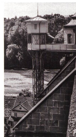
▲ 9 Der Aufzug von der Matte nach der Münster-plattform, im Volksmund «Senkeltram» genannt, ist mit seiner 32,5 m hohen Metallkonstruktion nicht mehr aus dem Stadtbild von Bern wegzudenken. Er wurde 1896 auf private Initiative hin erstellt und blieb, sieht man ab vom abendlichen Busbetrieb der BERNMOBIL-Linie 30, bis heute das einzige öffentliche Transportmittel des aare-nahen Quartiers. Juli 1996.
