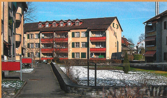
▲ 1 Zur Linderung der Wohnungsnot liess die städtische Bauverwaltung 1944–1946 die Siedlung Stöckacker errichten. Bis zu ihrem Abbruch 2013 war sie der älteste Zeuge öffentlichen Wohnungsbaus in Bern.
