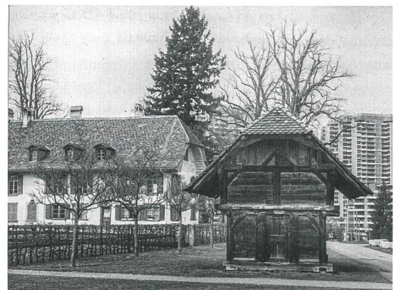
▲ 4 Der 1678 erbaute und später zweimal erweiterte Landsitz Brünnen und der 1986 von seinem ursprünglichen Standort an der Bottigenstrasse 2 A hierher versetzte Bümplizer Pfrundspeicher aus dem 18. Jahrhundert vor der Kulisse der 1979–1982 verwirklichten Überbauung Holenacker. März 1996.
