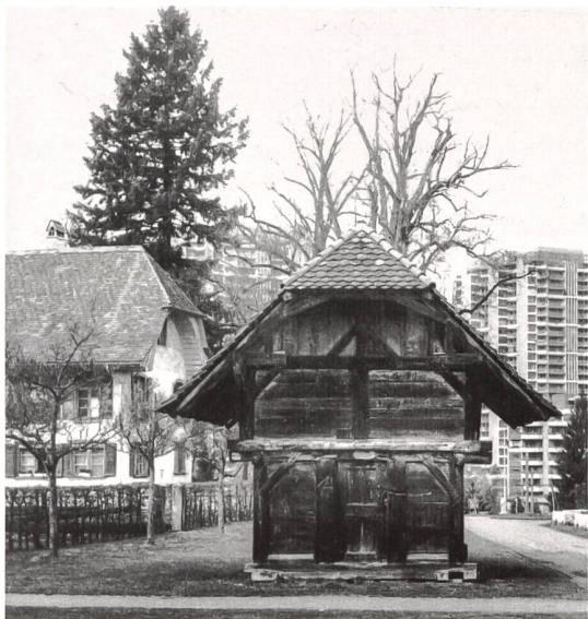
▲ 5 1986 wurde der Bümplizer Pfrundspeicher aus dem 17. Jh. zugunsten von Neubauten von seinem ursprünglichen Standort beim Bachmätteli verdrängt. Immerhin konnte er gemeinsam mit der zugehörigen Pfrundscheune auf der Autobahnüberdeckung beim Brännengut im Westen Berns neu aufgestellt werden. März 1996.
