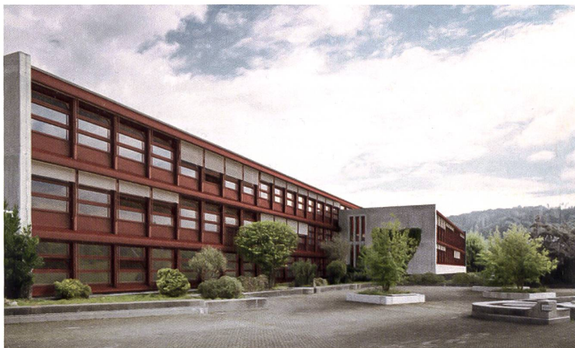
▲ 2 Visualisierung der geplanten Fassade aus vorfabrizierten Holz-Metall-Elementen, bei der die Plastizität der Bestandsfassade wiederaufgenommen wird.
