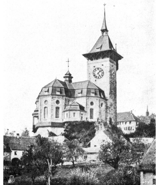
PFARRKIRCHE NIEDERGÖSGEN entstanden durch den Umbau der Ruine Gösgen-Falkenstein
