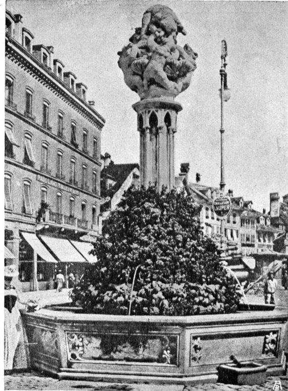
DER BÄRENBRUNNEN AUF DEM BÄRENPLATZ ZU BERN. Brunnensäule und Bekrönung stehen in keinem Verhältnis; der Blumenschmuck ziert nicht, sondern stört LA FONTAINE DES OURS A BERNE, avec ses proportions malheureuses
