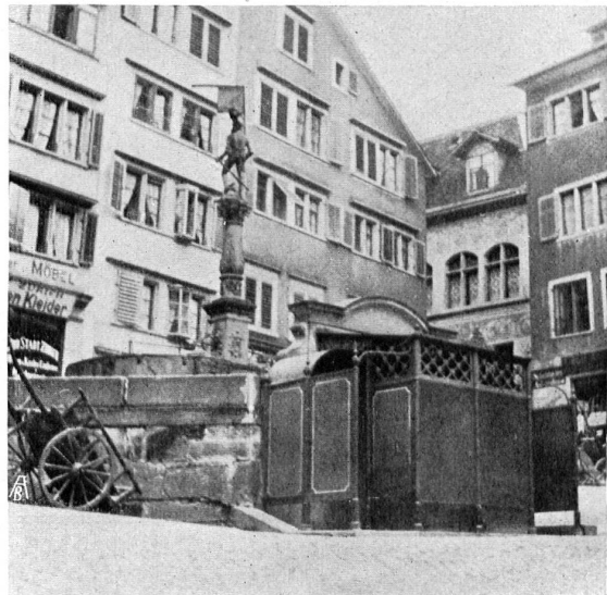
DER STÜSSIBRUNNEN auf der Stüssihofstatt zu Zürich. 1575 LA FONTAINE DE STÜSSI à Zurich. 1575
