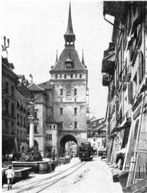
DER KÄFIGTURM IN BERN, erbaut 1641. Der linke Torbogen und das Treppentürmchen sind 1904 hinzugekommen; bis ins XIX. Jahrhundert war auch die Lücke rechts neben dem Turm überbaut
