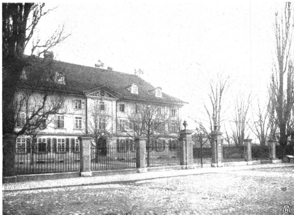
DAS WAISENHAUS IN BERN, einfacher aber wirkungsvoller Standesbau L'ORPHELINAT A BERNE, construction simple et belle ===== ===== Phot. Martin in Bern =====
