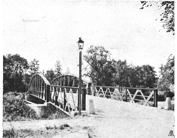
DIE NEUE ZIEGELBRÜCKE BEI BURGDORF, die an die Stelle der alten malerischen Holzbrücke gesetzt wurde. Man beachte die „stimmungsvolle“ Laterne NOUVEAU PONT PRÈS BERTHOUD. Une lanterne banale a remplacé le superbe arbre d'à côté. Le reste vaut ce détail
