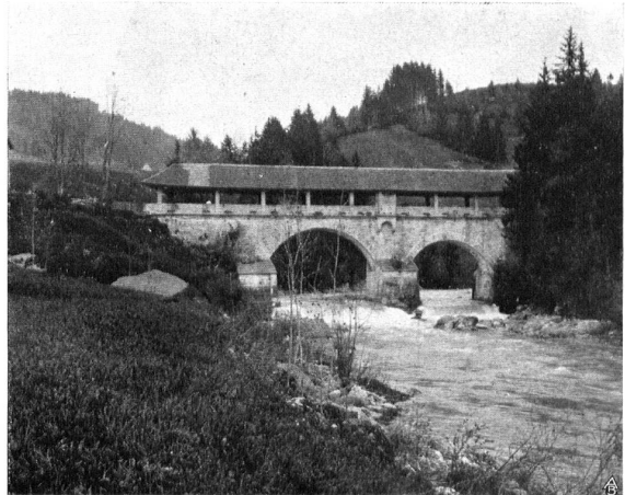
DIE TEUFELSBRÜCKE UBER DIE SIHL BEI EINSIEDELN. Beispiel einer alten gedeckten Steinbrücke. — Photographie von E. Ganz PONT DU DIABLE, SUR LA SIHL, PRÈS EINSIEDELN. Exemple d'un vieux pont couvert, en pierre. — Photographie E. Ganz
