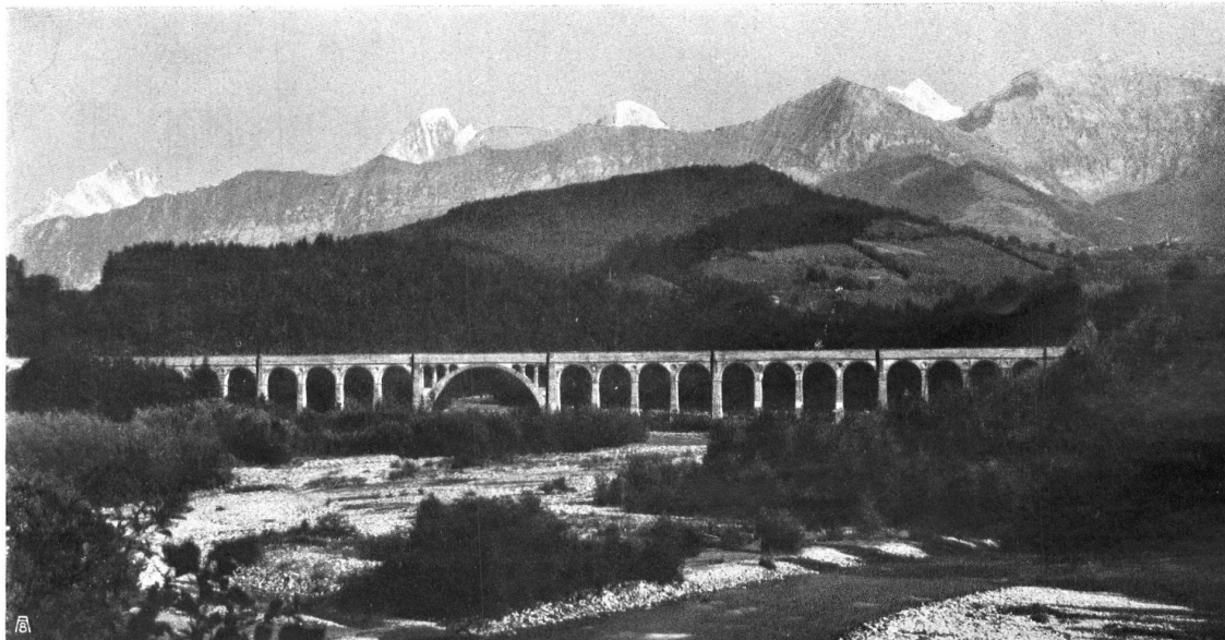
DER KANDERAQUÄDUKT DER KANDER-HAGNECKWERKE. ¶ Als vorzügliches Beispiel einer der grossartigen Landschaft aufs trefflichste angepassten gewaltigen Wasserüberführung. Entworfen und gebaut von der Firma Müller, Zeerleder & Gobat in Zürich und Bern. (Vergl. Zeitschriftenschau Seite 10 des Inseratenteils)
