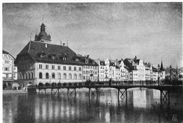
== PARTIE AN DER REUSS 1908. Fast die ganze Häuserreihe wird durch protzige Umbauten alter behäbiger Häuser unruhig und unschön == == LA REUSS EN 1908. Contraste frappant d'un édifice ancien avec la ligne agitée des maisons récentes ==
