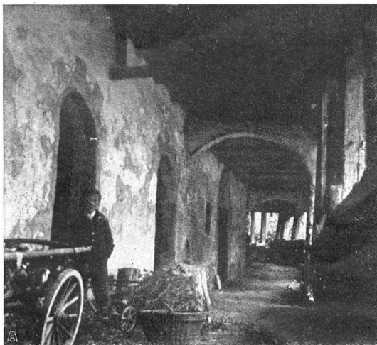
LAUBEN IN WERDENBERG. Die Stützen sind Edelkastanienstämme. Einfache Malereien umrahmen die Hauseingänge TROTTOIR COUVERT A WERDENBERG; la poutraison en bois de châtaignier. Les portes des maisons encadrées de peintures très simples
