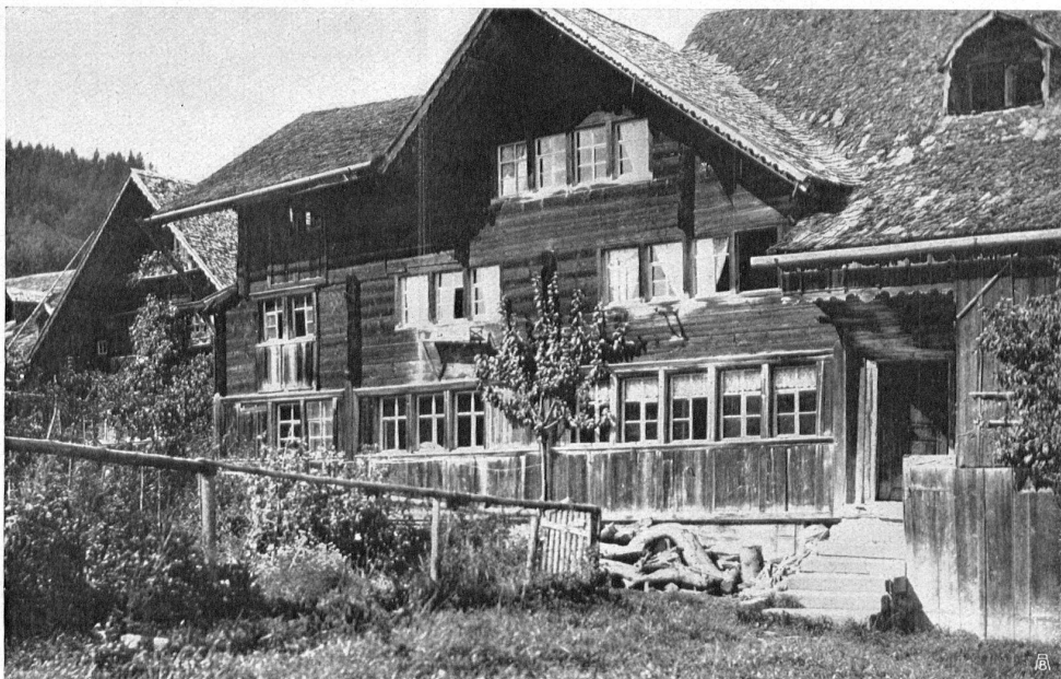
ANSPRECHENDES GUTERHALTENES HAUS AUS DEM XVII. JAHRHUNDERT am Fussweg von Heiden auf den Kayen ——— Besitzer: Hr. Schläpfer ——— ——— MAISON DU XVII e SIÈCLE, fort bien entretenue, sur le sentier de Heiden à Kayen. Propriété de M. Schläpfer ———
