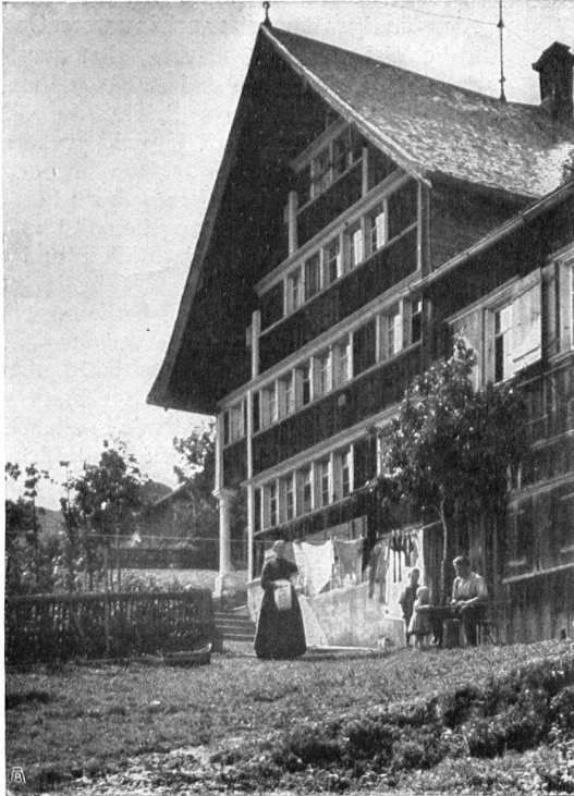
HAUS AUS DEM ANFANG DES XIX. JAHRHUNDERTS AUF BRUNNEN-HEIDEN. Besitzer: Hr. Graf A BRUNNEN-HEIDEN. COMMENCEMENT DU XIX e SIECLE Propriétaire M. Graf
