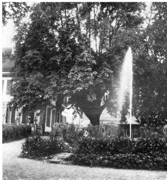
Blick in den Hof. Im Hintergrund zwischen den herrlichen alca- Bäumen steht der übel angebrachte moderne Kiosk Vue de la cour; au fond, entre les arbres majestueux, un kiosque mesquin
