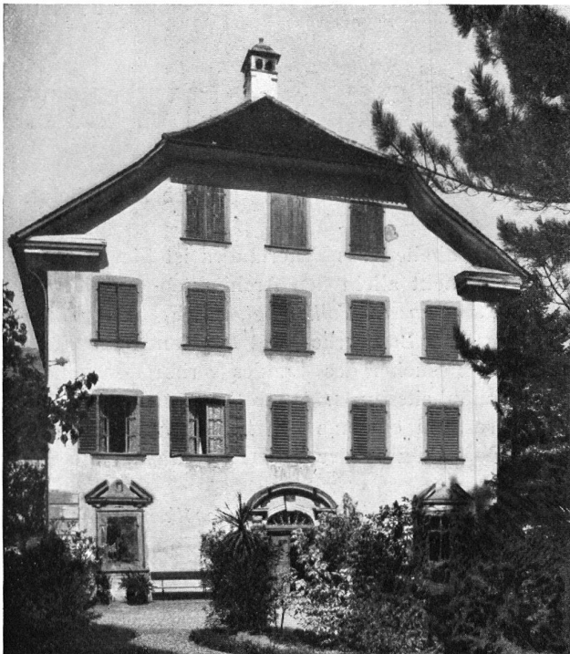
Altdorf. Haus Crivelli an der Herrengasse.
