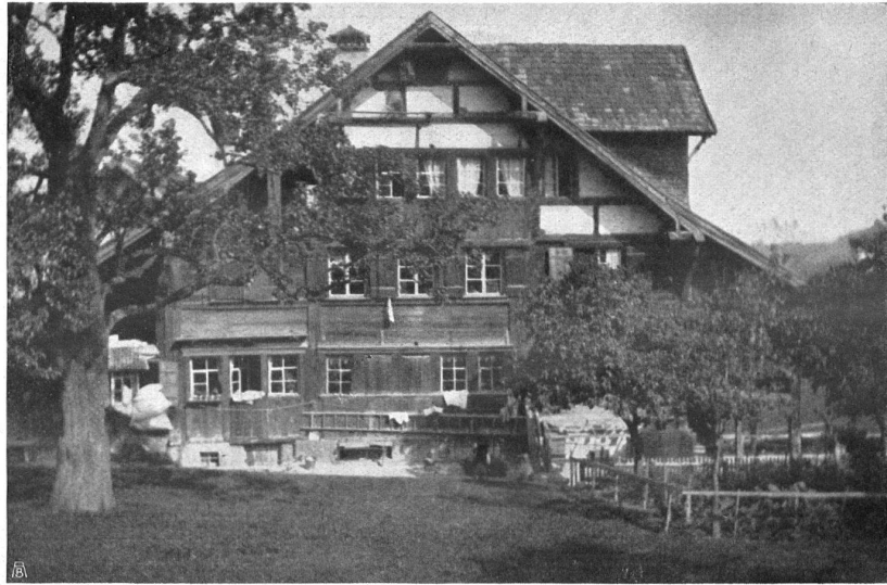
== HAUS AM „WEG“ == UNE MAISON DE ST-FIDEN
