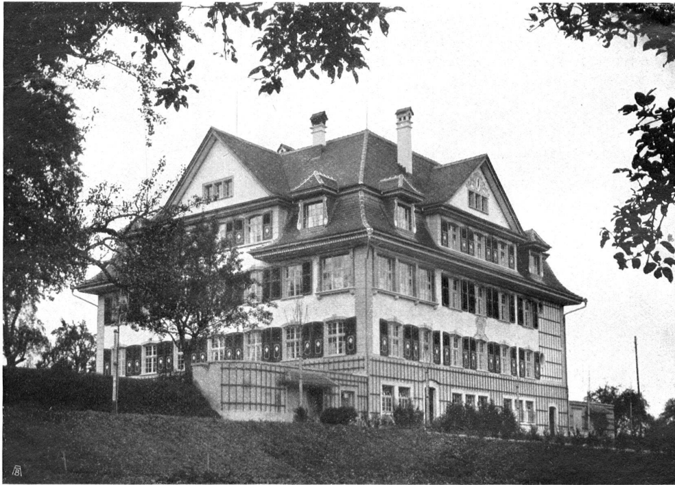
ANSICHT VON DER STRASSE
