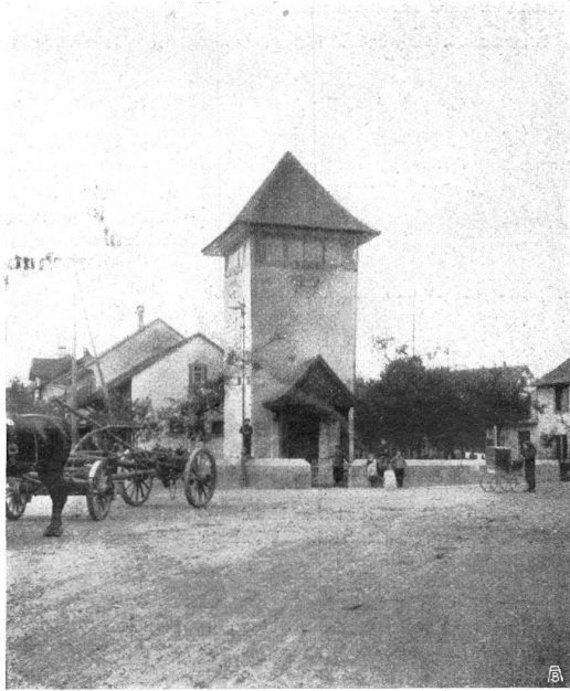
Abb. 20. BEISPIEL. Transformatoren-Häuschen in Thayngen, das sich in seinen ruhigen, zweckentsprechenden Formen der Umgebung gut einpasst.
