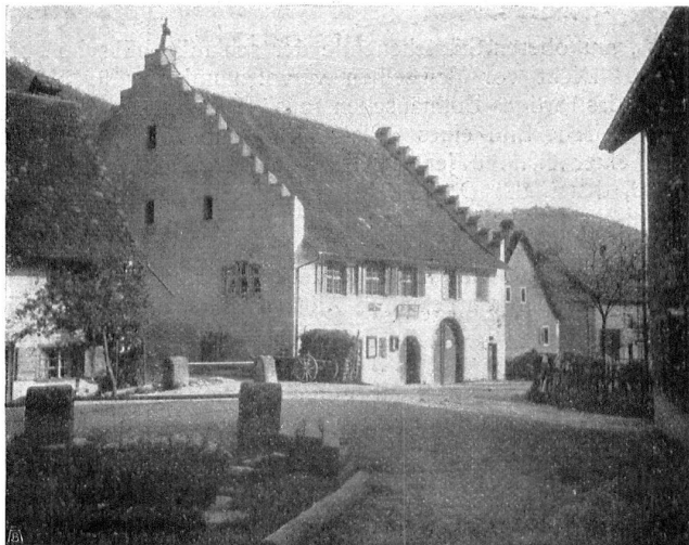
Abb. 2. Gemeindehaus in Merishausen in typisch schaffhauserischem Charakter. Fig. 2. Maison communale de Merishausen. Intéressant type de l'architecture schaffhausoise.
