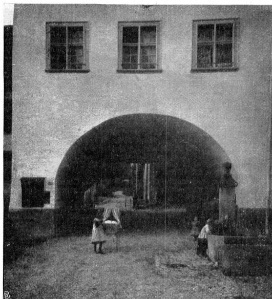
Abb. 25. Verbindungsbogen in Wilchingen, charakteristisch für die Dörfer des unteren Klettgaues. — Fig. 25. Passage voûtée à Wilchingen. Caractéristique pour les villages du Klettgau.
