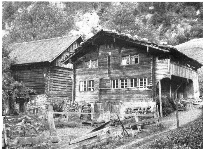
Abb. 10. Altes Bauernhaus in Erstfeld, „in der Halde“, mit neuem Stall. — Photographie von Dr. K. Gisler, Altdorf.
