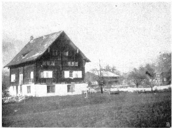
Abb. 6. Haus im „unteren Hof“ in Schattdorf, erbaut von Leutnant Jost Ant. Tresch († 1724). — Fig. 6. Ferme dans le „untern Hof“ à Schattdorf, construite par le lieutenant Jost Ant. Tresch († 1724). Photographie de M. le Dr K. Gisler, Altdorf.
