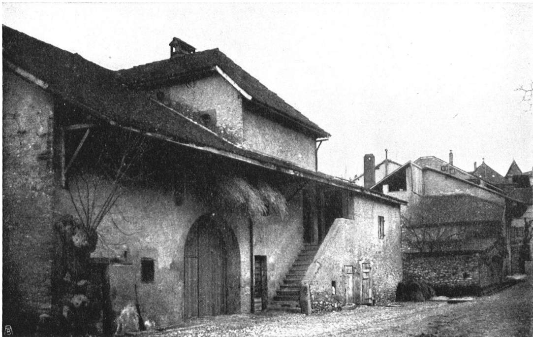
Fig. 15. Pittoresque groupement d'une maison rurale et de ses dépendances; remarquer la belle porte cintrée de la grange. Cliché R. Gilli , Genève. — Abb. 15. Malerische Gruppe eines Bauernhauses und seiner Nebengebäude. Bemerkenswert ist der schöne Türbogen der Scheune. Aufnahme von R. Gilli , Genf.
