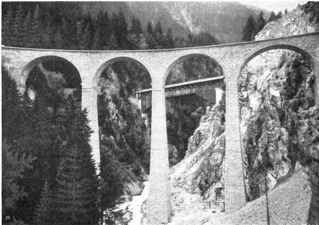
Abb. 5. Viadukt Val Russein der neuen Linie Ilanz-Disentis der Rät. Bahn; hinten die alte Holzbrücke. Auch diese Steinbrücke der Rät. Bahn ist ein Kunstwerk, das die Grossartigkeit der Natur nur unterstützt, nicht schädigt. Aufnahme von Huonder, Disentis. — Fig. 5. Le viaduc du val Russein, Nouvelle ligne Ilanz-Disentis des chemins de fer rhétiques. Ce magnifique pont de pierre au lieu d'enlaidir la nature lui apporte au contraire un attrait nouveau. Cliché Huonder, Disentis.
