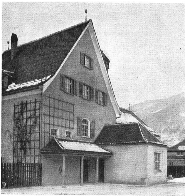
Abb. 16. Badhaus in Landquart. Gruppierung am Eingang. Die schön geschwungenen Dachlinien und ihr gut vermitteltes Ineinanderspielen wirken als köstliche Zierde des Hauses. Aufnahme D. Mischol, Schiers. — Fig. 16. Etablissement de bains à Landquart. La composition de l'entrée, les lignes élégantes du toit donnent à ce bâtiment un cachet très artistique.
