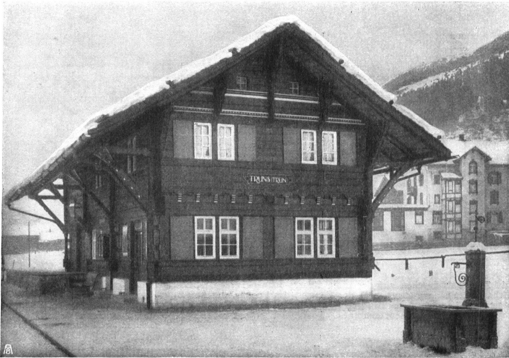
Abb. 5. Stationsgebäude in Truns (Linie Ilanz-Disentis). Ein rassiger, mit Schnitzerei und Bemalung geschmückter Holzbau. Aufnahme von Carl Lang , Chur. — Fig. 5. Gare de Truns (Ligne Truns-Disentis). Solide construction de bois ornée de sculptures rehaussées de couleurs.
