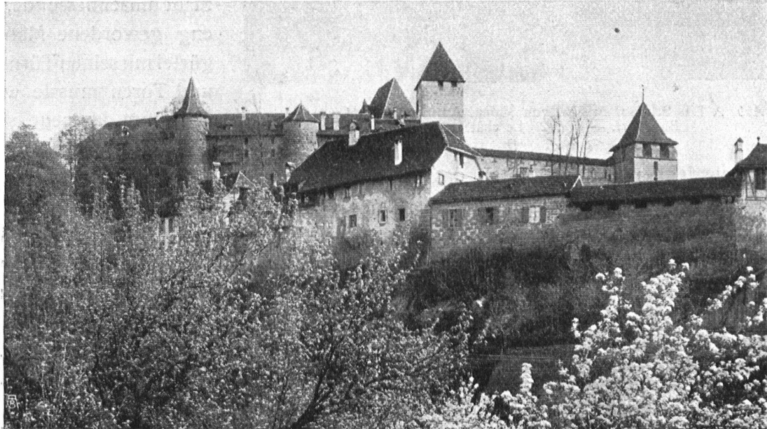
Abb. 1. Schloss Burgdorf, Nordfront. Davor die letzten Reste der Ringmauer und der, von ihnen umschlossene, alte Markt. Aufnahme von L. Bechstein, Burgdorf. — Fig. 1. Le château de Berthoud, vue du Nord. Devant le château quelques parties conservées de l'ancien mur d'enceinte et de l'ancien marché.
