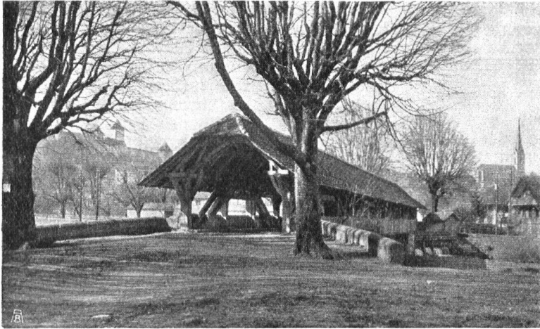
Abb. 11. Innere Wynigenbrücke. Eine der wenigen erhaltenen Holzbrücken der Gegend; die breit ausladende Masse der Brücke ist in schönem Einklang mit dem Bild der alten Burg, das links sichtbar wird. Aufnahme von L. Bechstein, Burgdorf. — Fig. 11. Vue intérieure du pont de Wynigen. Un des rares ponts conservés dans la contrée. Les larges proportions du pont sont en belle harmonie avec la silhouette du vieux château qu'on aperçoit à gauche.
