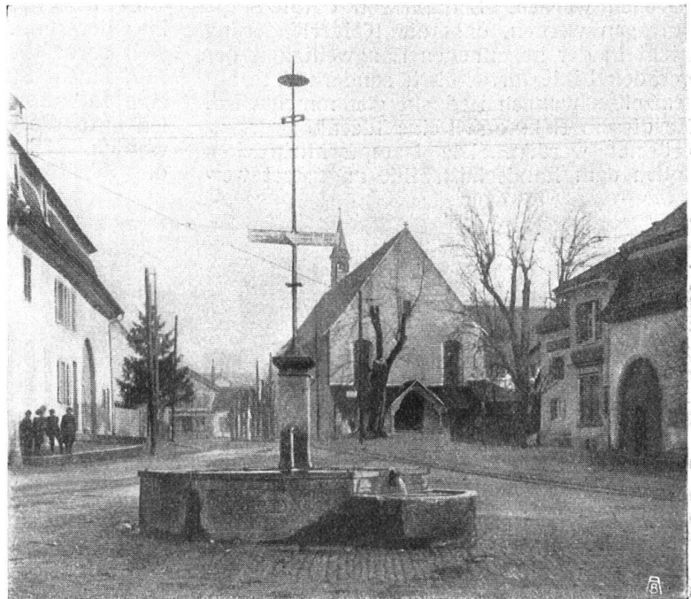
Abb. 19. Brunnen in Dornach-Bruck, dessen Pfeiler Wasserröhren trägt und ausserdem einen Blumenständer, einen vierseitigen Wegweiser, Leitungsdrähte und eine elektrische Lampe. — Fig. 19. Fontaine à Dornach-Bruck, dont la colonne porte des tuyaux, une jardinière, un quadruple indicateur, des câbles électriques et une lampe électrique.
