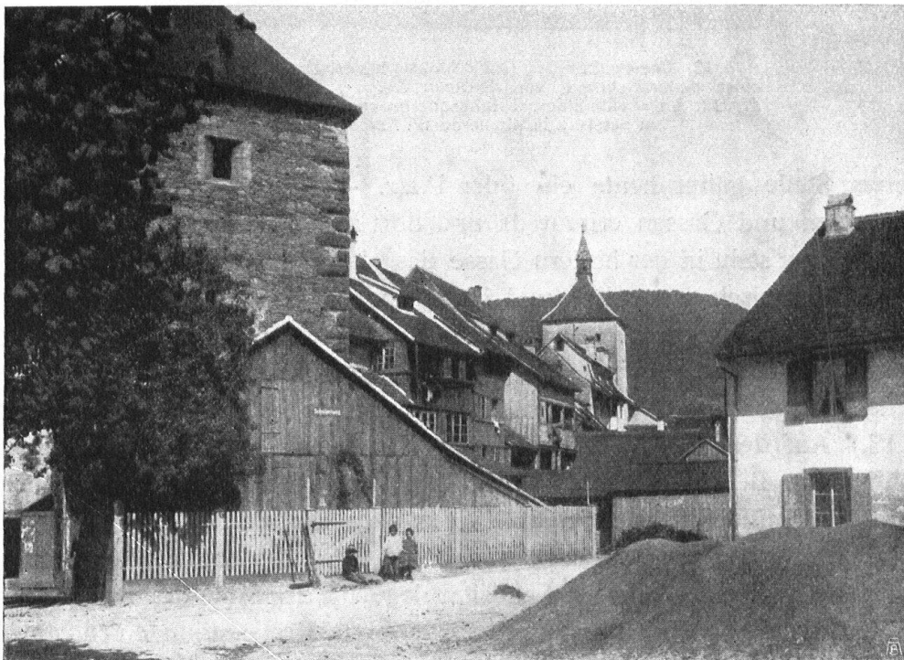
Abb. 11. Häuserpartie — teilweise zur Stadtmauer gehörend — zwischen dem „obern Tor“ und dem vor zehn Jahren geschleiften Wasserturm. Aufnahme von Arnold Seiler, Liestal. — Fig. 11. Groupe de maisons qui font partiellement partie des remparts et sont situées entre la «Tour supérieure» et l'emplacement de l'ancien «Wasserturm».
