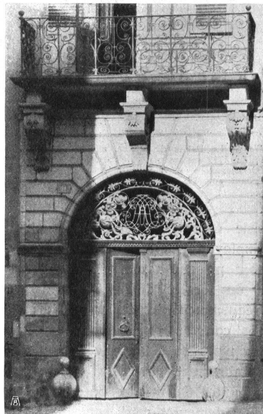
Fig. 4. Porte de belle allure (17 e siècle, 1681) ancienne maison Calandrini, façade sur la rue du Puits St. Pierre. Cliché Boissonnas. — Abb. 4. Schönes Portal aus dem Ende des 17. Jahrhunderts, am früheren Haus Calandrini, von der Fassade gegen den Puits St. Pierre.
