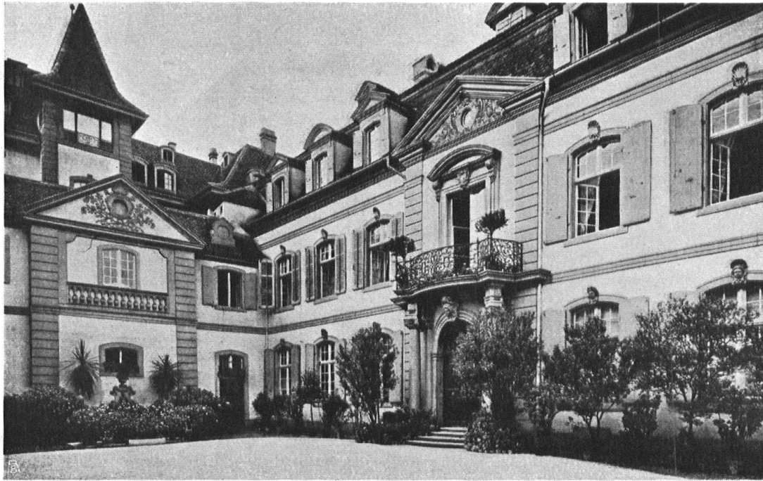
Abb. 9. Innere Hauptfassade des Ramsteinerhofes. Fig. 9. Façade principale, donnant sur la cour du Ramsteinerhof.
