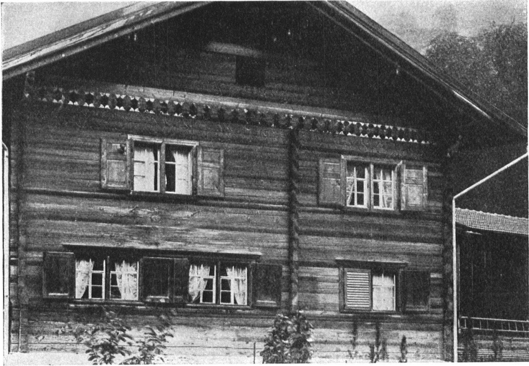
Abb. 10. Haus in Grüşch. Fassade mit Spruch und Malerei. (Vergl. Abb. 3.) Fig. 10. Maison à Grüşch; façade avec devise et peinture. (cf. fig. 3.)
