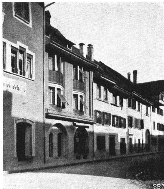
Abb. 17. Fremdartiger Neubau in Neunkirch. Fig. 17. Construction nouvelle hétérogène à Neunkirch.
