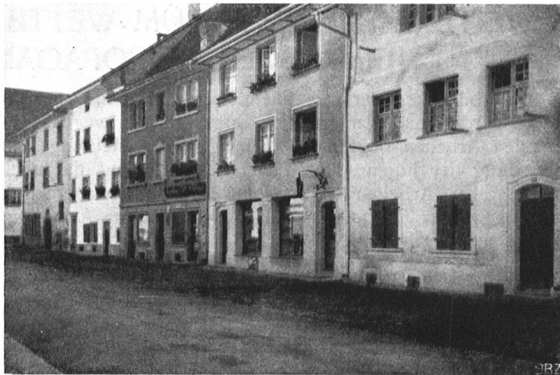
Abb. 18. Gute Anpassung des Schuhmacherhauses an die schlichtbürgerliche Bauweise der Nachbarbauten. — Fig. 18. La maison du cordonnier s'harmonise bien avec la simplicité du style bourgeois des maisons voisines.
