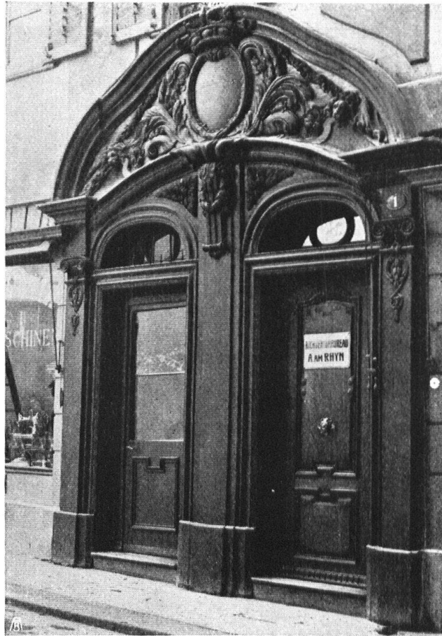
Abb. 18. Schlechtes Beispiel. Durch eine banale Emailtafel wird die hervorragend schöne alte Holztüre im einzelnen wie im Gesamteindruck verunziert. — Fig 18. Mauvais exemple. Cette banale plaque d'émal détonne comme une fausse note au milieu d'une magnifique porte de chêne ancienne.
