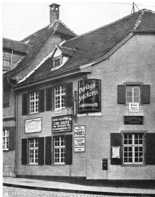
Abb. 20. Schlechtes Beispiel. Mit Firmentafeln überladenes Haus. Zerrissener Eindruck wegen der Wahllosigkeit in der Anordnung, den Formaten, der Ausführung. — Fig. 20. Mauvais exemple. Façades surchargées d'enseignes et d'écriteaux disparates.
