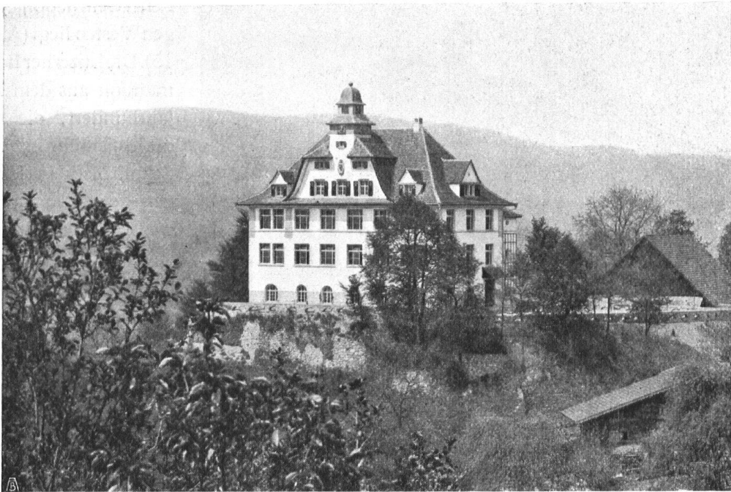
Abb. 9. Das Burgschulhaus in Büron. Auf dem ehemaligen Burghügel erbaut, beherrscht die Schule das Dorfbild. Der elegante Giebelaufbau bildet wirkungsvoll ein Gegengewicht zu den zwei Fensterreihen. Architekten Meili-Wapf & Amberg , Luzern. — Fig. 9. Maison d'école à Buron. Elevée sur l'ancien « Burghügel », cette école domine le village. Le pignon aux lignes élégantes forme un contraste plein d'effet avec les deux rangées de fenêtres au-dessous.
