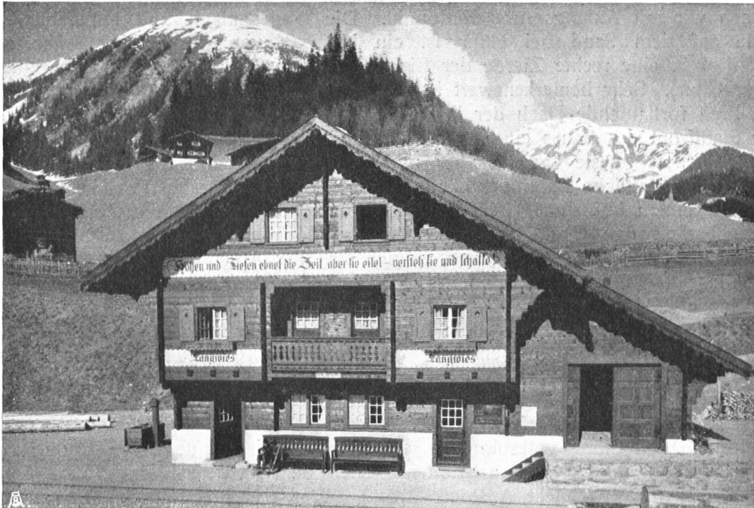
Abb. 15. Bahnhof Langwies. Die bodenständige Holzbauweise hat da eine kunstvolle und praktisch sehr brauchbare Weiterbildung gefunden. Architekt B. S. A. A. Rocco , Arosa. Aufnahme von Albert Steiner , St. Moritz. Fig. 15. Gare de Langwies. L'architecture en bois du pays a trouvé ici une heureuse application.
