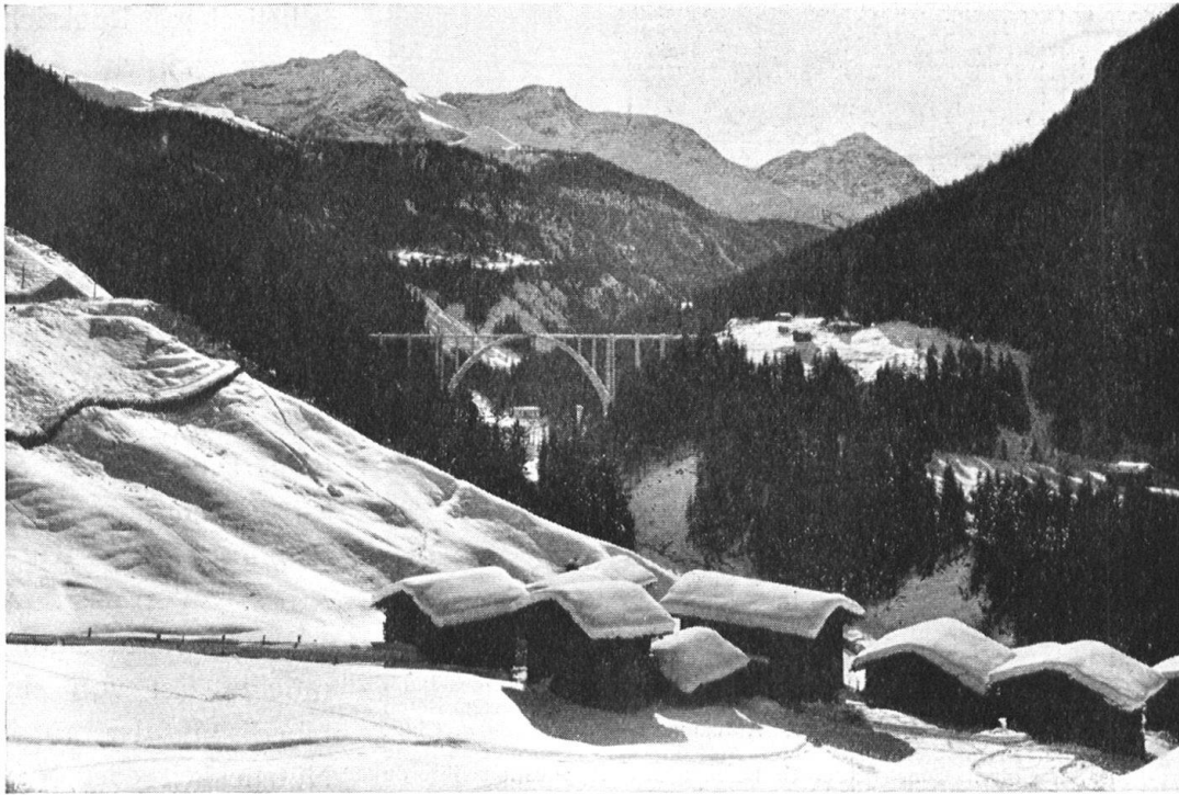
Abb. 7. Langwieser Viadukt. Eine der schönsten Eisenbahnkunstbauten der Schweiz, bemerkenswert durch die elegante Linienführung, die auch die Kraftanspannung — im Spiel der Widerstände an der Bogenbasis — ahnen lässt. Aufnahme von A. Reinhard , Chur. — Fig. 7. Le viaduc de Langwies. Une des plus belles constructions de ce genre en Suisse, remarquable surtout par la hardiesse et l'élégance de ses formes.
