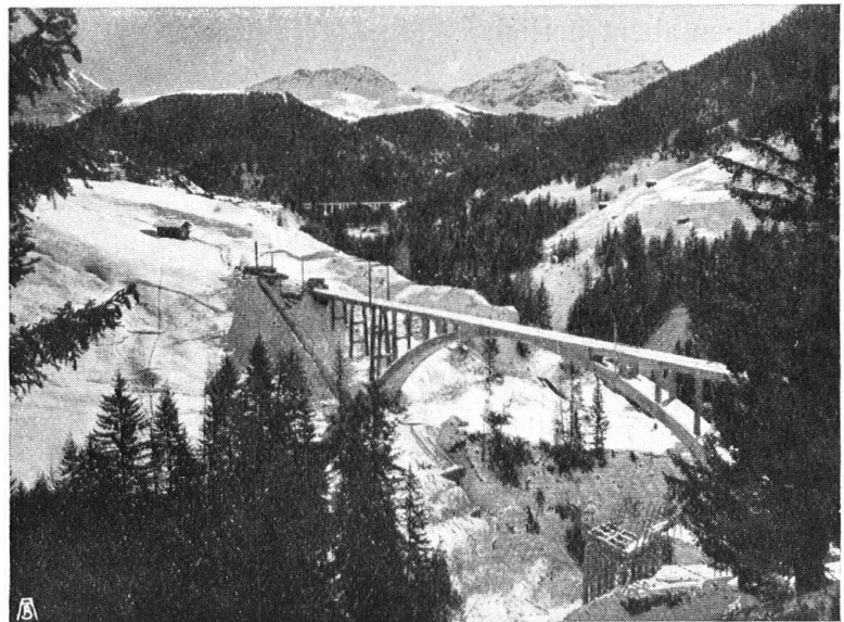
Abb. 6. Gründje-Tobel-Viadukt mit Langwieser Viadukt im Hintergrund. Bogen aus armiertem Beton. Firma Müller, Zeerleder & Gobat . Aufnahme von A. Reinhard , Chur. — Le viaduc du torrent de Grundje; au fond le viaduc de Langwies. Arches en béton armé.
