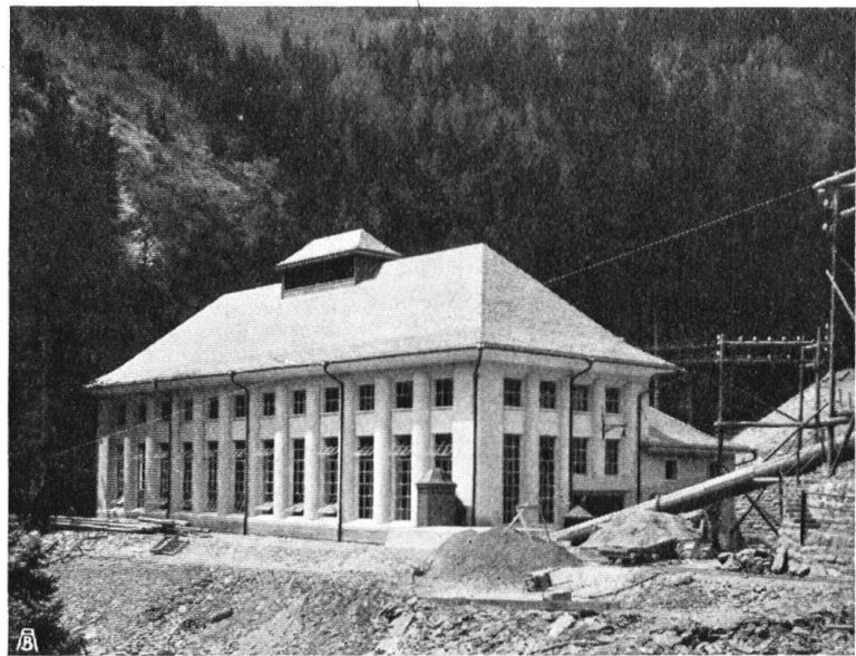
Abb. 10. Maschinenhaus des Elektrizitätswerkes der Stadt Chur. Durch gute Proportionen und streng durchgeführte Gliederung wichtig und schön wirkende Nutzbau, der trefflich in die raue Umgebung passt. Architekt B. S. A. Willi, Chur. Aufnahmen von A. Reinhard, Chur. — Fig. 10. La halle aux machines de l'usine électrique, à Coire. Des proportions justes, des lignes vigoureuses, la sévère régularité des divers éléments donnent à ce bâtiment un caractère très approprié au paysage ambiant.
