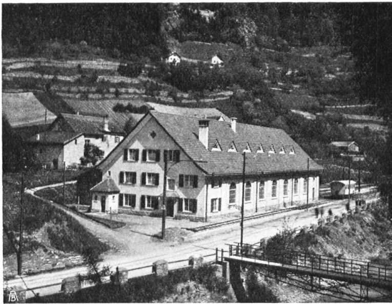
Abb. 9. Werkstätte, Remise und Depotchefwohnung der Chur-Arosa-Bahn in Chur. Mit freier Anlehnung an bündner Formen ganz in armiertem Beton erstellt. Architekt B. S. A. Manz, Chur. Aufnahme von A. Reinhard, Chur. — Fig. 9. Ateliers, remise et habitation du chef du dépôt central de la ligne Coire-Arosa, à Coire. Construction en béton armé. Application libre de formes d'architecture grisonne.
