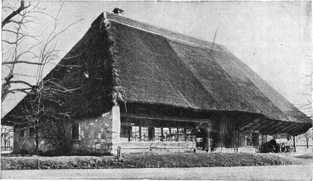
Abb. 12. Strohhaus in Buchs bei Aarau. Dieser typische Bau ist vom Konsumverein Buchs auf Abbruch gekauft worden. Hoffentlich wird s. Z. ein tüchtiger Architekt mit dem Neubau betraut; an Stelle des alten Musterbaues sollte etwas möglichst Gleichwertiges gesetzt werden! Aufnahme von P. Siegwart, B. S. A., Aarau. — Fig. 12. Ferme couverte d'un toit de chaume à Buchs, Argovie. Cette construction très caractéristique a été achetée pour être démolie par la société de consommation de Buchs. Espérons qu'un architecte capable sera chargé de la construction de la nouvelle maison et que celle-ci fera honneur à l'ancien bâtiment.
