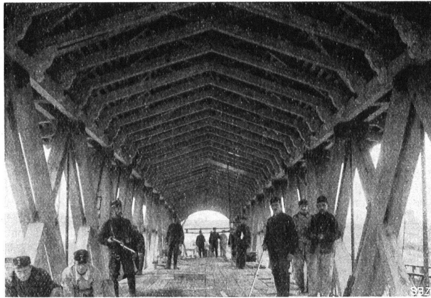
Abb. 17. Innenansicht der neuen Birnbrücke bei Münchenstein, die durch schweizerische Genietruppen erbaut wurde. — Fig. 17. Vue intérieure du nouveau pont construit par les troupes du génie, à Münchenstein.
