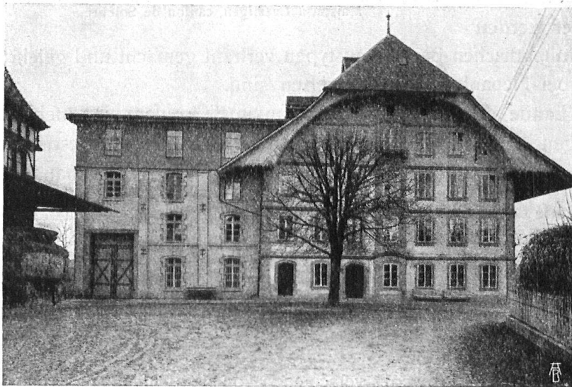
Abb. 17. Gegenbeispiel. Verunstaltung eines guten älteren Hauses durch das Anfüllen eines formlosen Nutzbaues. Falsche Verbindung des alemannischen Daches mit dem flachen Holzzementdach. Mühle in Langenthal. — Fig. 17. Mauvais exemple. Belle maison bernoise complètement enlaidie par l'adjonction d'un bâtiment aux formes disgracieuses, dont le toit plat jure avec le beau pignon de l'ancienne construction: Moulin à Langenthal.
