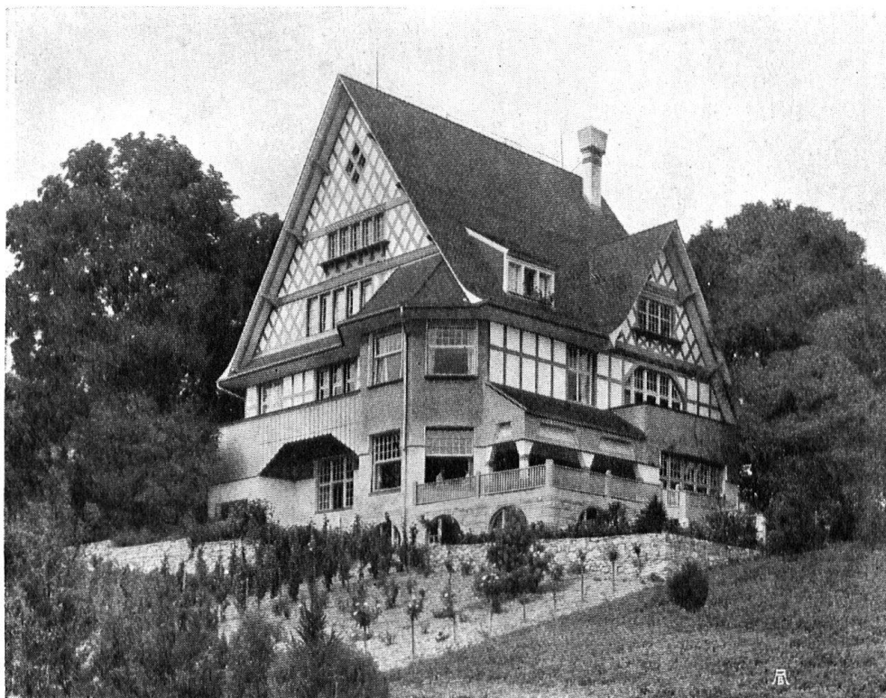
Abb. 11. Modernes Landhaus, bei dem Fachwerkbau, Schindeln und Holzverschalung Verwendung fanden. Landhaus Obereggbühl bei Höngg (Kanton Zürich). Architekt Max Müller, z. Z. Gemeindebaumeister in St. Gallen. — Fig. 11. Villa moderne. L'architecte s'est servi de motifs d'architecture indigène: murs en colombage, revêtement de boiseries et de clavins. Maison de campagne à Obereggbühl, près Höngg (Zürich). Architecte Max Müller, actuellement architecte de la ville, St-Gall.
