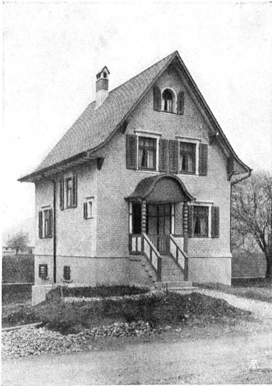
Abb. 16. Eternit in gefälliger Anordnung und Form als Wandverschindelung. — Fig. 16. Emploi judicieux de l'éternite comme revêtement. Bon goût dans la forme et la combinaison des matériaux.
