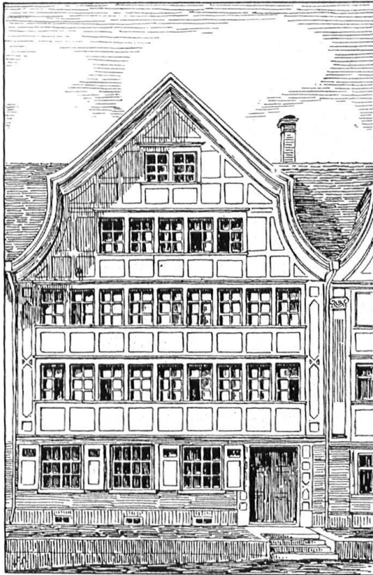
Abb. 7. Gestricktes Haus mit vollständig vertäferter Front. Hinter der Täferung laufen die Aufzugladen. Am Dorfplatz in Gais. — Fig. 7. Maison en colombage dont la façade est complètement boisée. Place du Marché à Gais.
