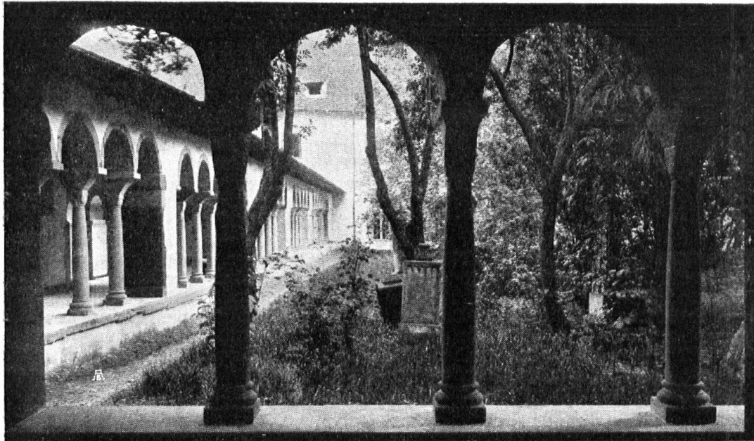
Abb. 13. Nordseite des Kreuzganges, vom Westflügel aus gesehen. Aufnahme von C. Koch. — Fig. 13. Côté nord du cloître, vu de l'ouest.
