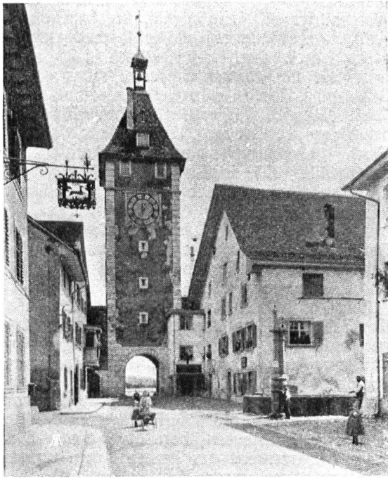
Abb. 15. Obertorturm in Neunkirch. Vor der Wiederherstellung. Man beachte die im Anfang des 19. Jahrhunderts aufgemalte hässliche Quader- und Eckbinder-teilung. Aufnahme von C. Koch, Schaffhausen. — Fig. 15. La tour de la Porte supérieure à Neunkirch, avant la rénovation. Remarquer les laides imitations peintes de pierres de taille.
