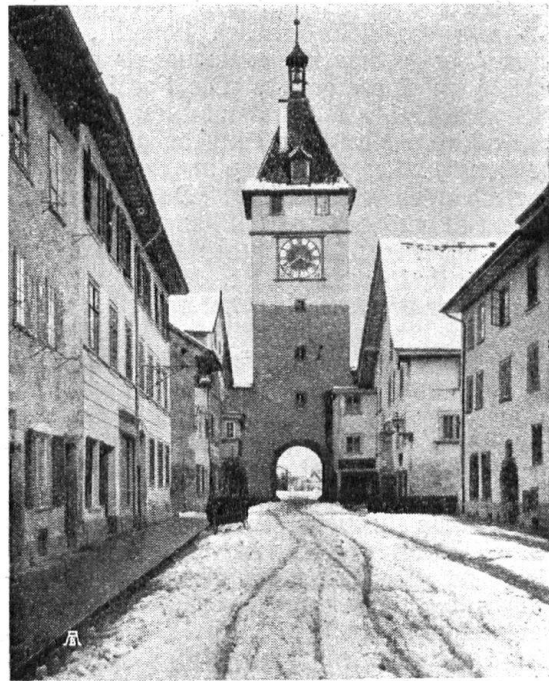
Abb. 16. Obertorturm in Neunkirch. Heutiger Zustand. Die überflüssige Dekorationsmalerei ist beseitigt und der Turm erscheint wehrhaft und schlicht wie ehemals. Aufnahme von C. Koch. — Fig. 16. La tour de la Porte supérieure à Neunkirch dans son état actuel. Les décorations superflues ont été supprimés. La tour a beaucoup gagné en retrouvant son air simple et martial.
