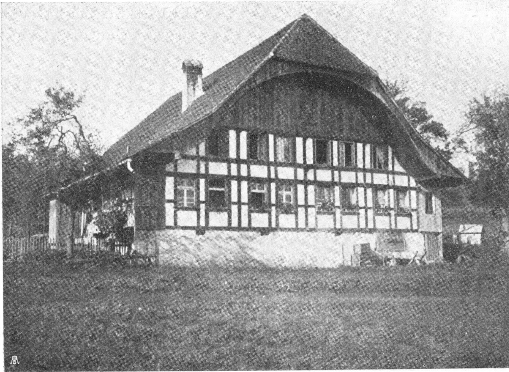
Abb. 14. Uetendorf. Fachwerkhaus. Das Fachwerk hat keine Streben. Fig. 14. Uetendorf. Construction en pans de bois.
