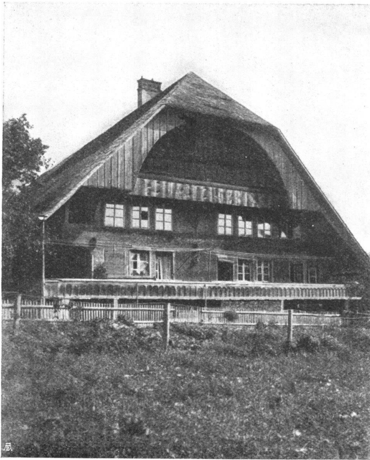
Abb. 10. Seftigen. Haus mit Schindelverkleidung und Schindeldach. Fig. 10. Seftigen. Maison dont les murs et le toit sont revêtus de bardeaux.
