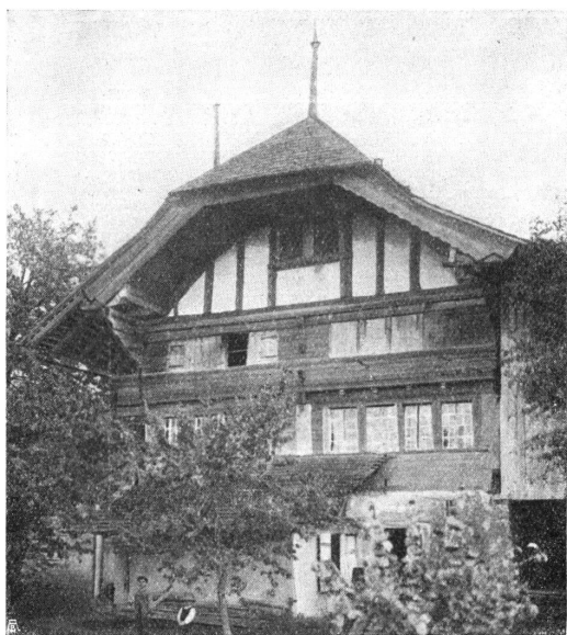
Abb. 3. Lattigen bei Spiezmoos. Blockbau mit Fachwerk im Giebel. (Das Haus hat an der Traufseite einen Turm mit Wendeltreppe.) — Fig. 3. Lattigen, près Spiezmoos. Mur de poutres horizontales. Pignon fermé d'un mur en pans de bois. La maison est flanquée d'une tour avec escalier tournant.
