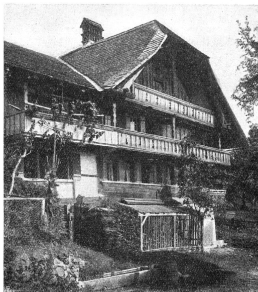
Abb. 4. Heimberg. Hauptbau mit Ständerwand. Die Flug- oder Stützdreiecke am Giebel sind sichtbar. Anbau in Fachwerk. — Fig. 4. Heimberg. Construction principale en murs faits de poutres verticales. Sur les côtés du pignon constructions additionnelles en pans de bois.
