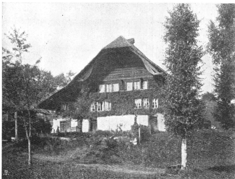
Abb. 12. Bühl bei Amsoldingen. Ständerbau mit sichtbarer Konstruktion des bogenförmigen Giebels. — Fig. 12. Bühl, près Amsoldingen. Murs faits de poutres horizontales. Pignon découvert.
