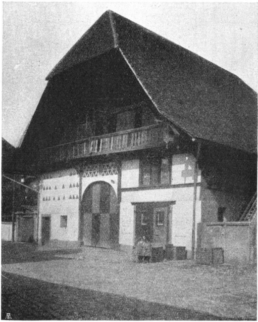
Abb. 12. Thun. Scheune mit Stallungen an der Hintern Gasse; stattliches ländliches Bauwerk in der Stadt. — Fig. 12. Thoune. Grange et écuries sur la rue de derrière; architecture cosvue de paysans riches en ville.
